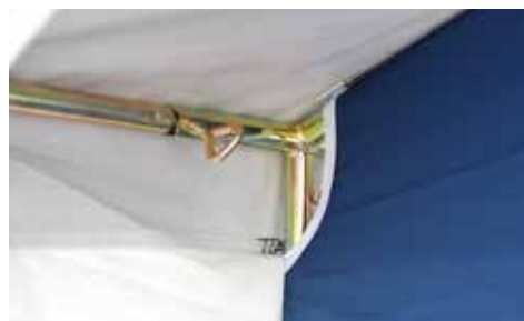
Struttura in acciaio
